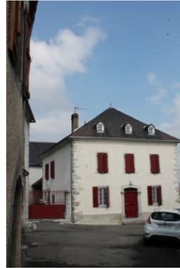
Lorsque le bâtiment comporte des ouvertures sur deux niveaux, on note que celles-ci sont le plus souvent superposées et ceci autant dans un esprit de rationalité constructive que dans un véritable esprit de composition (le vide de l'ouverture permet de décharger le linteau en dessous).
