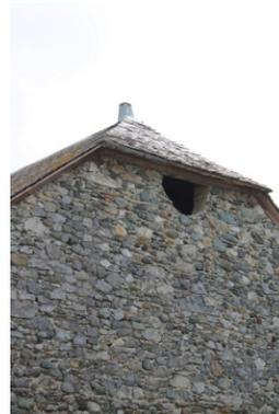
Le comble servait d'entrepôt de grains et de fourrage. Une ouverture ronde ou en demi cercle dans le pignon surmonté d'une croupe était utilisée pour la ventilation
