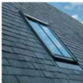
Les produits proposés dans les gammes « patrimoine » par les constructeurs s'insèrent discrètement dans les pans de toiture. Ici la fenêtre de toit s'apparente à une tabatière tout en respectant les spécificités technique. Aucun élément n'est en saillie par rapport au toit.
