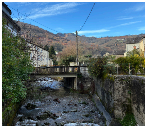
3363 Bielle rue de la mairie.
